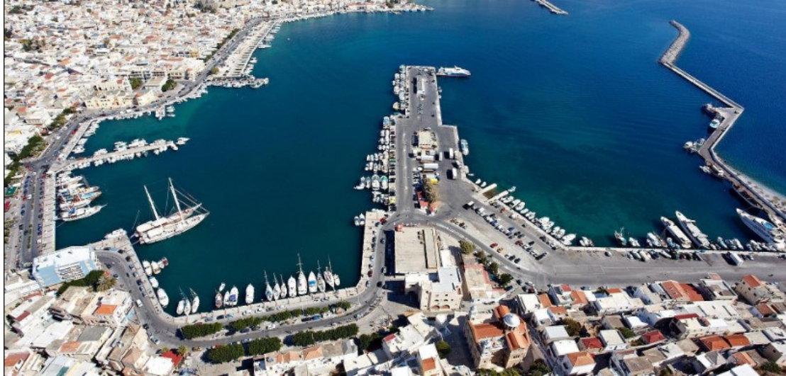
Εικόνα 3: Άποψη λιμένα Καλύμνου.
