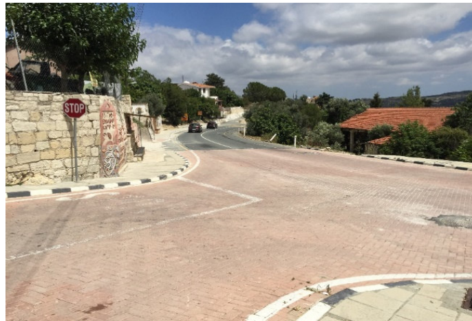
Εικόνα 24: Πλατό οδοστρώματος στην Κύπρο.
